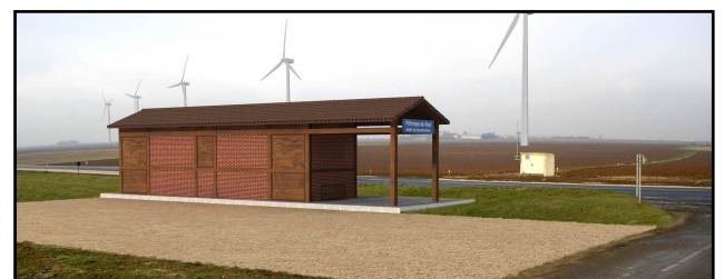
Le poste de livraison électrique, intégré en une petite gare ferroviaire.
